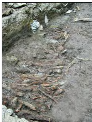
Fig. 4 Canale ottocentesco coperto con tronchi (foto Co.IDRA)
