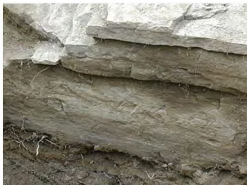
Figura 2 Tracce dei tagli ottocenteschi realizzati con piccone nel banco di arenaria (foto Co.IDRA)
