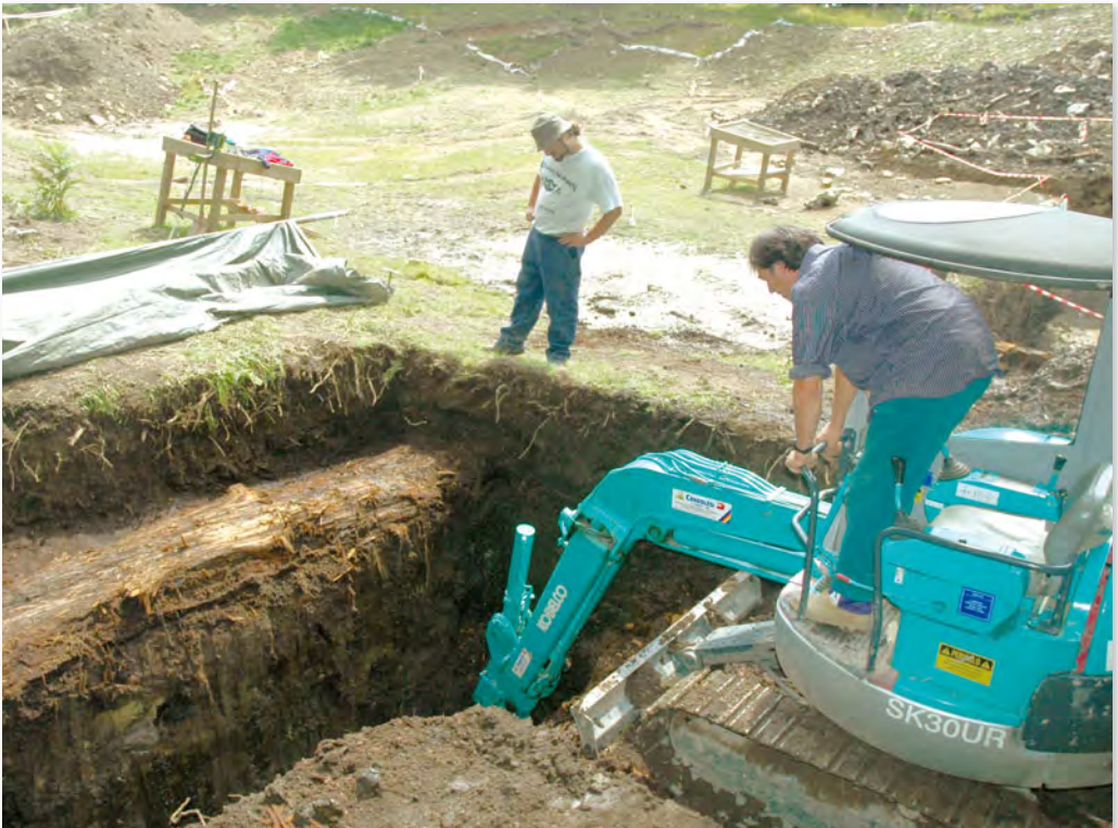
Fig. 9 Escavatore in fase di lavoro (foto Co.IDRA)
